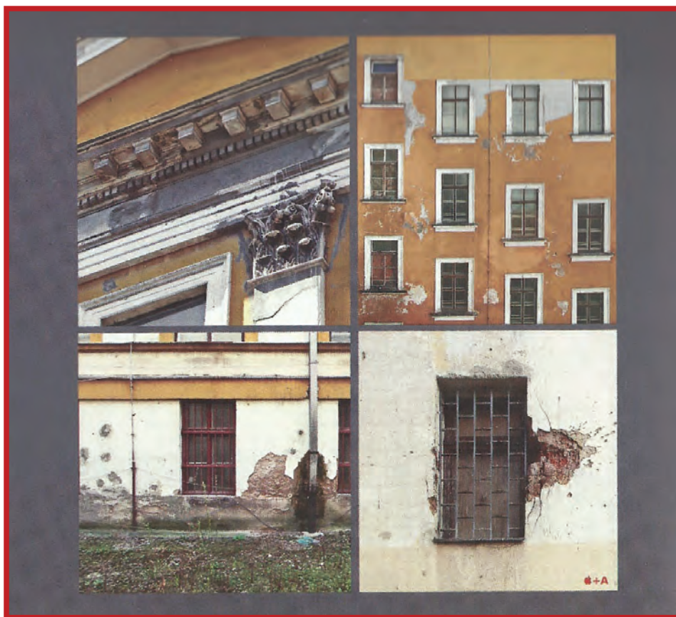
Fotografija 42. Oštećenja nastala uslijed vremenskih uticaja i granatiranja (&+A) – Ammar Akšamija, Dženis Avdić i / “Arhiv Akšamija” Sarajevo, 2021)
